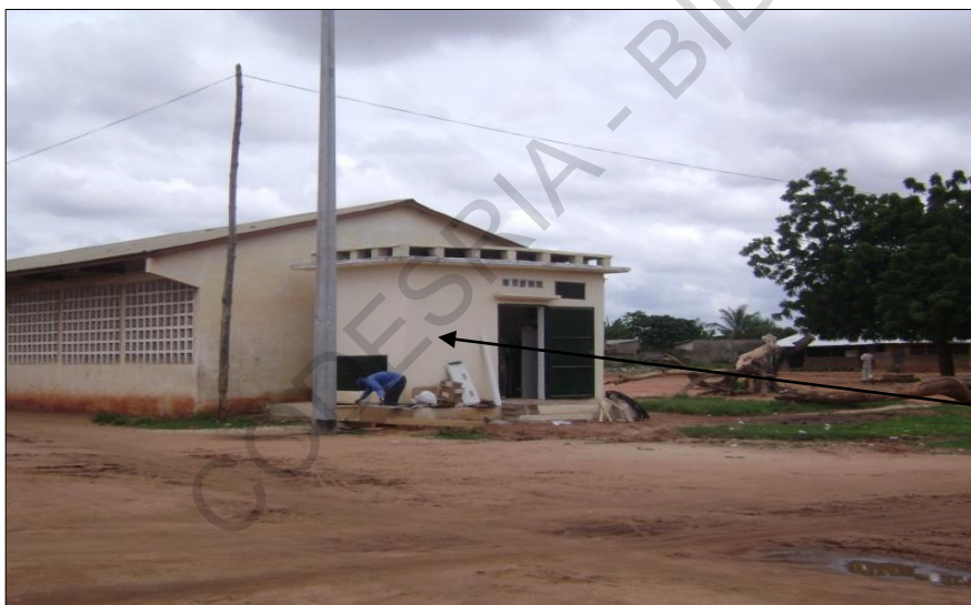
Photo 6. 11: Construction d'un poste de transformation de haute tension à Vakpossito
