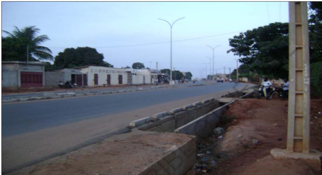
Photo 6.1 : Vue d'un tronçon de la bretelle Adidogome-Avédji-Agoènyivé
