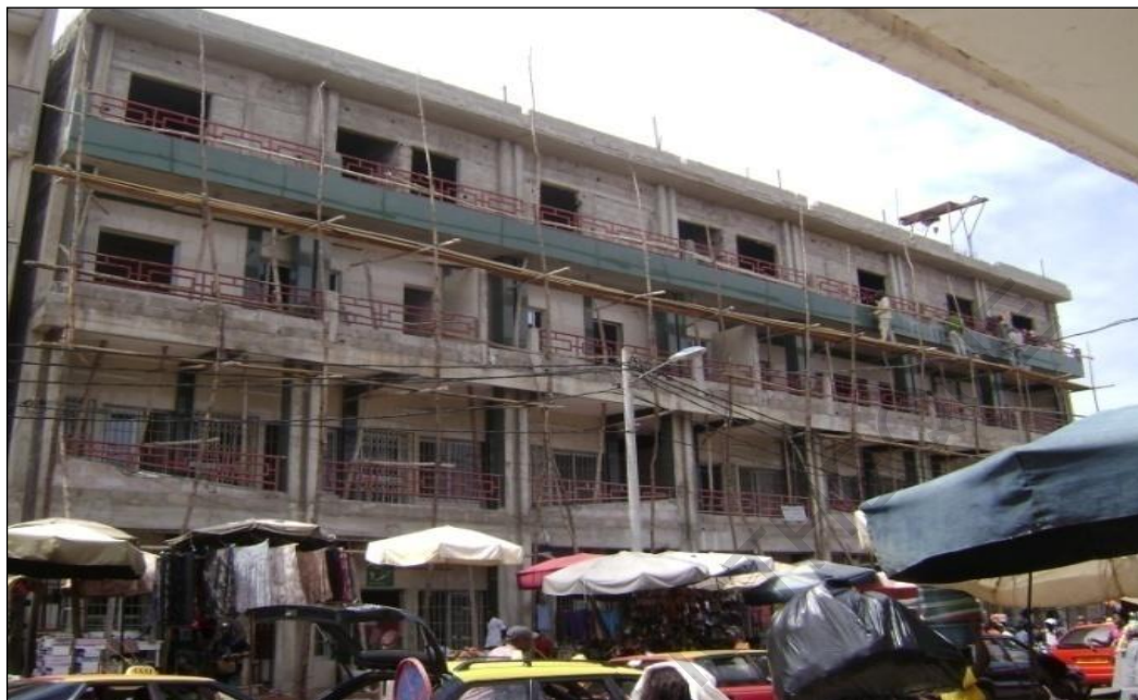
Photo 3.1 a : Travaux d'extension et d'augmentation des niveaux d'un immeuble au grand marché de Lomé
