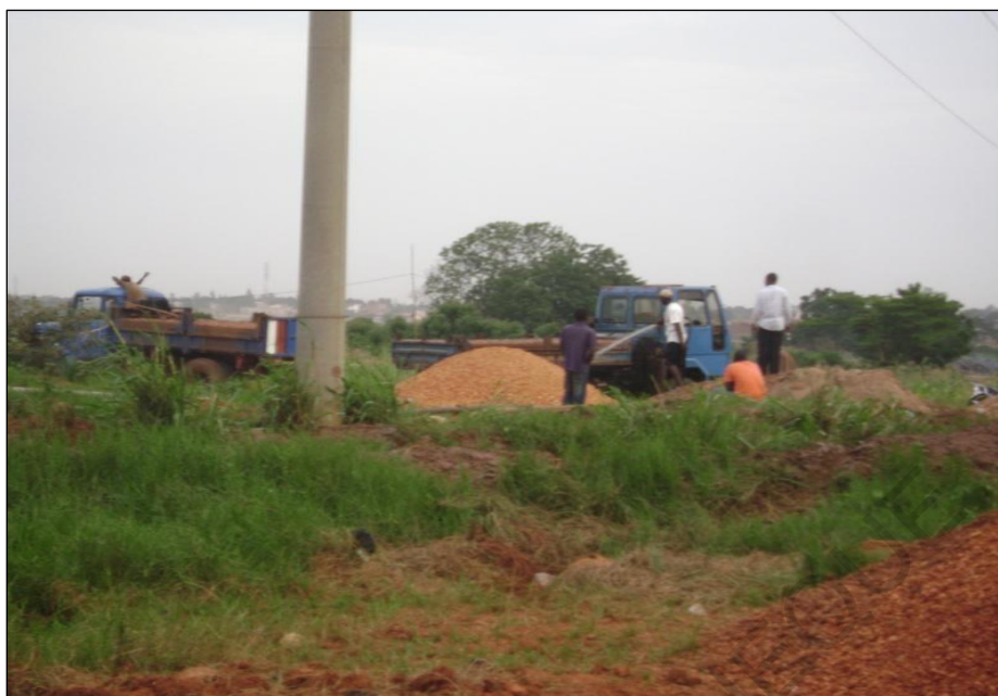
Photo 4.6 b : Chargement de gravier à Agoènyivé Zongo terminal du sahel
