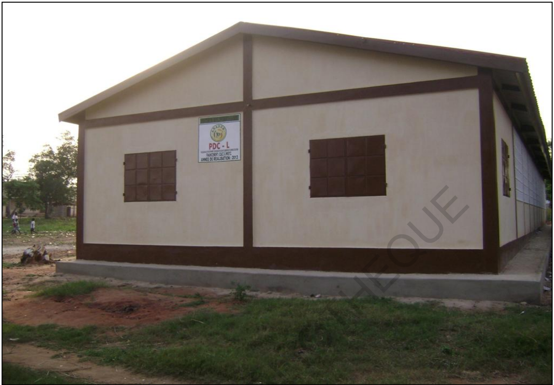
Photo 8.1: Bâtiment scolaire construit dans le cadre du PDCL dans la périphérie nord de Lomé
