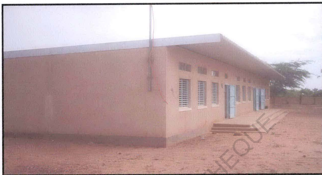
Photo n°4 : Nouveau bâtiment de l'école
